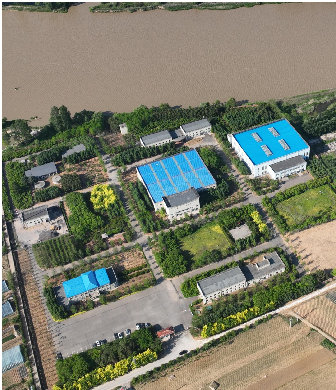
■ 现状庄河净水厂建筑风貌
